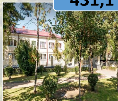
Строительство здания детского сада по ул.Г.Медиков 5
