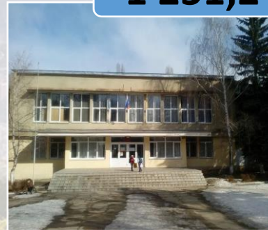
Реконструкция МБОУ СОШ №15
