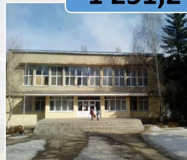
Реконструкция МБОУ СОШ №15
