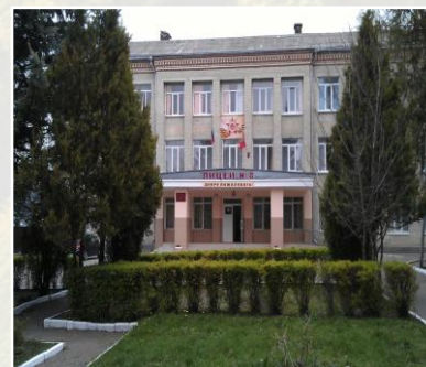
Пристройка здания начальной школы МБОУ «Лицей № 8»;
