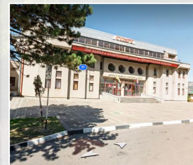
Реконструкция МБУДО ДЮСШ N 1
