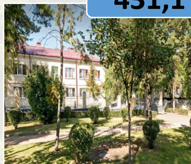
Строительство здания детского сада по ул.Г.Медиков 5
